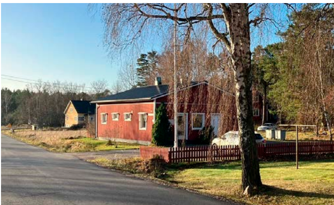
Bageribyggnaden på Tallbackavägen Leipomorakennus Mäntymäentiellä
