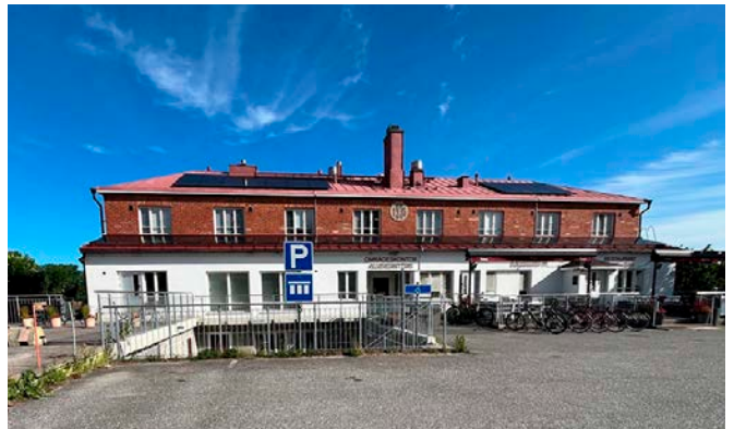
Stabshusets södra fasad Stabshusetin eteläjulkisivu
