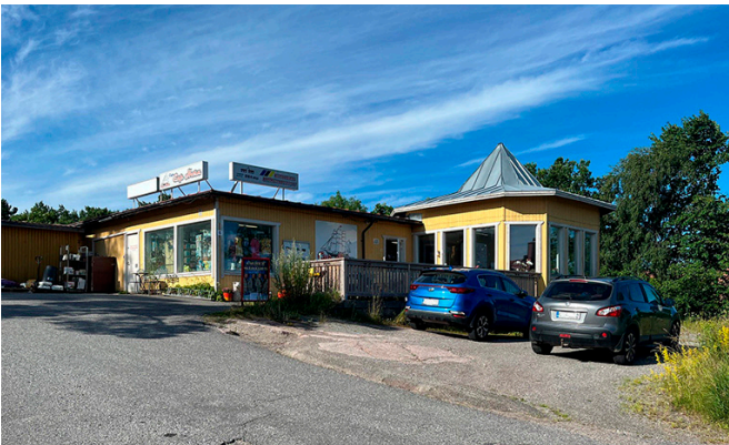
Affärsbyggnaden på Handelsmansvägen Liikerakennus Kauppamiehentiellä
