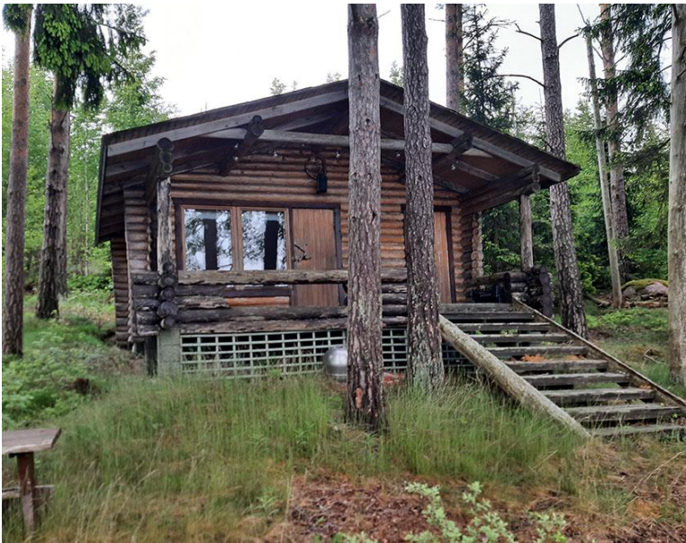
Kuva 7. Nygrannaksen kantatilalle kuuluva rantasauna osoitetaan ranta-asemakaavaan M-alueelle rakennusalanana sa/30.
