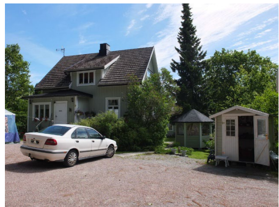
Huvudbyggnaden på fastigheten Päivärinne 2:58. Kiinteistön Päivärinne 2:58 päärakennus. Foto/Valokuva: Turun kaupunginmuseum/Museon informaatioportaali TKM/MIP, Teija Mustonen.
