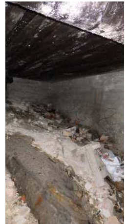
8. Ryömintätilasta tarkastettuna kohdissa jossa alapohja ei vielä ole sortunut niin näkyi laajoja mikrobi-/lahovaurioita alapohjan aluslaudoissa.
