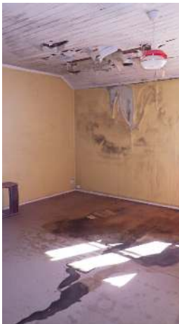
21. Sisäpinnoilla mikrobivaurioita
