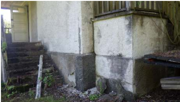
1. Sokkelipinnoite laajalti irronnut
