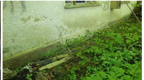
2. Sokkelipinnoite laajalti irronnut
