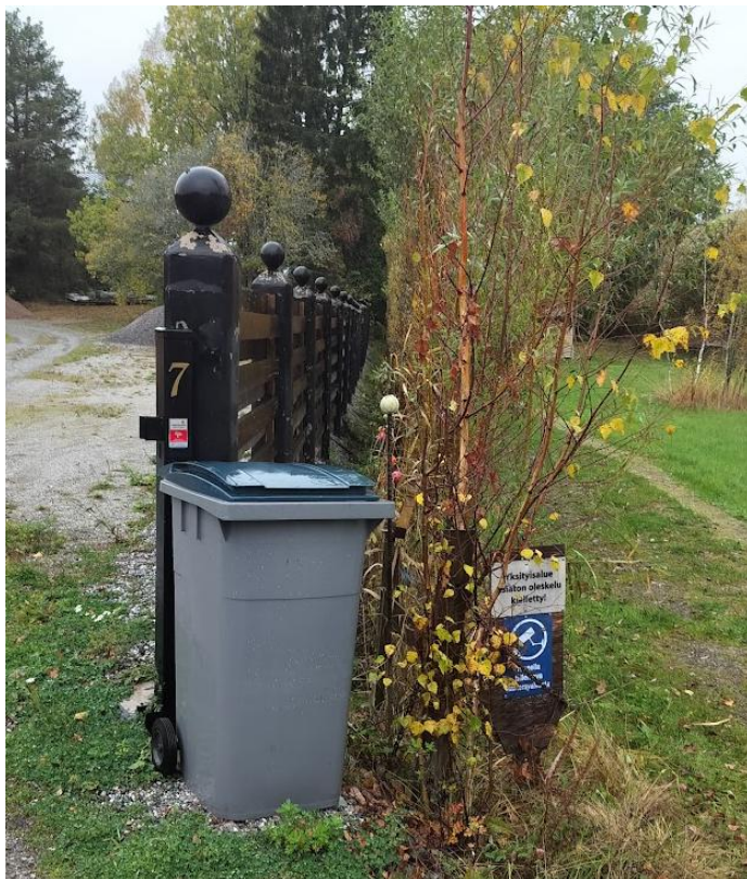
Bild 1. Första stolpen vid grinden ca 57cm från rån, där bollarna på armeringsjärnen syns.
