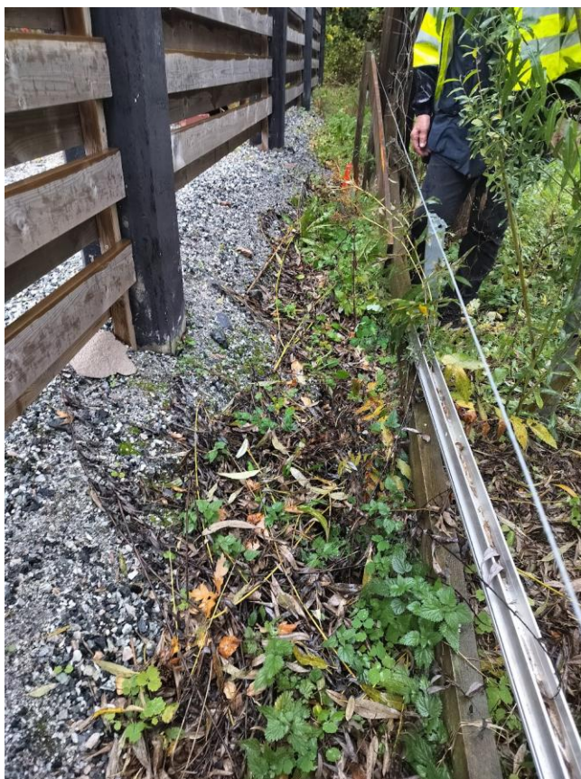
Bild 2. Metalltråd som är uppdraget som rålinje.
