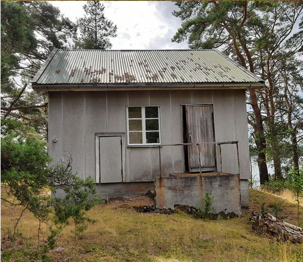
Kuvat 4-5. Talviväylän lossipaikan asemarakennus (vartiotupa) osoitetaan kaavassa talousrakennukseksi. Julkisivumateriaalina on käytetty Paraisilla toimineen teollisuuslaitoksen 1950-60-lukujen tuotannon hittituote mineriittilevy. Sotien jälkeen tuotettiin kuvissa 2-3 olevan luotsiaseman julkisivumateriaalina mineriitipikkulevy, sekin aikansa menestystuote. Saaressa on useita jäännöksiä aikojen saatossa puretuista talousrakennuksista sekä vanhoja kaapeleita ja johtoja. Rakennuksen koko on 32 m 2 ,
