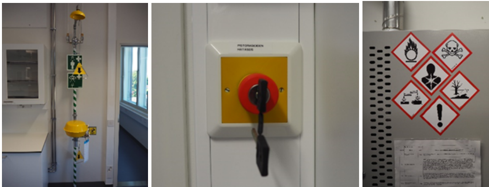
Hätäsuihku, silmäsuihku, hätäkatkaisin ja turvamerkinnät kemikaalikaappien ovissa
