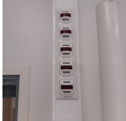
Hälytysvalo WC:n yläpuolella ja kanslian hälytyspaneeli
