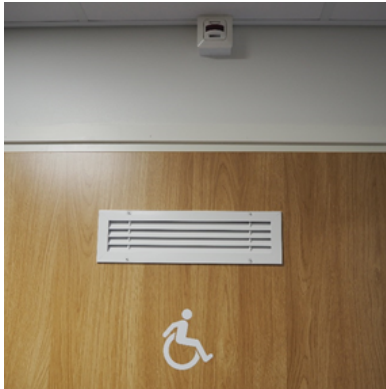
Hälytysvalo WC:n yläpuolella ja kanslian hälytyspaneeli
