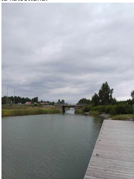
Sundsbron och servicebryggan från söder. Suntinsilta ja asiointilaituri etelästä katsottuna.
