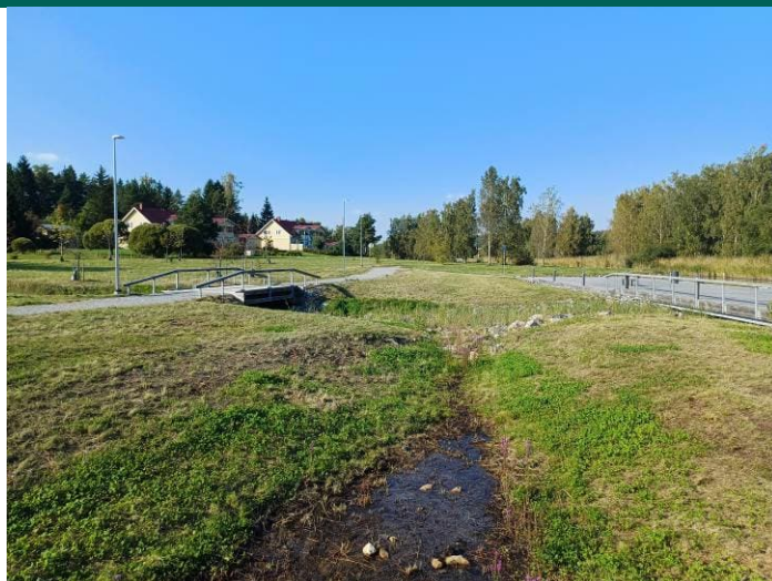
Anlagd våtmark för hantering av dagvatten. Rakennettu kosteikko hulevesien käsittelyä varten.
