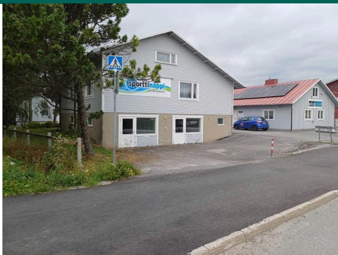
Utsikt från Norrby strandväg till industrikvarter 4, tomt 4. Byggnaden har i byggnadsinventeringen klassificerats som landskapsmässigt värdefull. Näkymä Norrbyn rantatieltä teollisuuskorttelin 4, tontille 4. Rakennus on rakennusinventoinnissa luokiteltu maisemallisesti arvokkaaksi.
