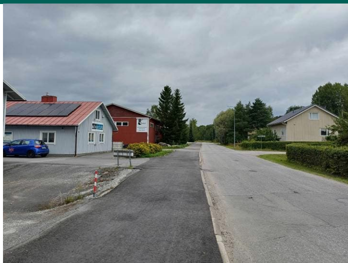
Byggnadsbeståndet på Norrby strandväg, från korsningen mellan Norrby strandväg och Lv 180 Skärgårdsvägen norrut. Rakennuskantaa Norrbyn rantatiellä, sen ja Mt 180 Saaristotien risteyksestä pohjoiseen.
