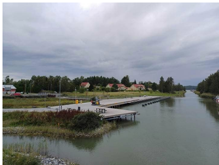
Servicebryggan väster om Kyrksundet. Asiointilaituri länsipuolella Kirkkosalmee.
