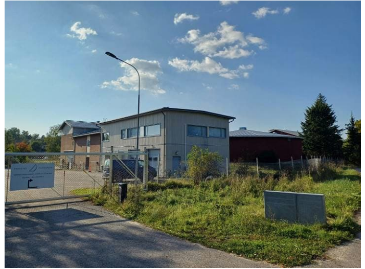
Reningsverket från sydöstra delen av Norrby strandväg. Jätevedenpuhdistamo kaakosta Norrbyn rantatieltä katsottuna.
