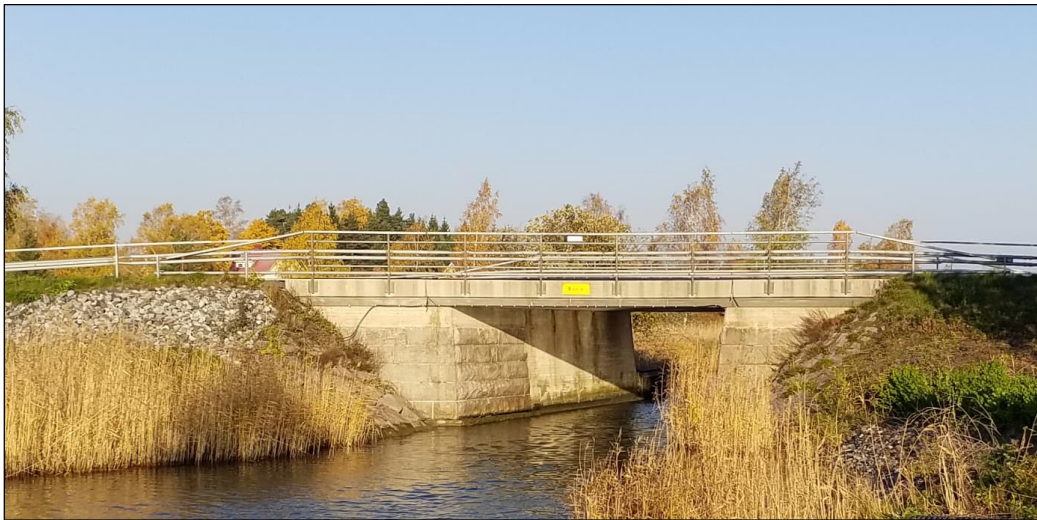
Kuva 21. Kirkkosalmen sillan T-157 kiviset maatuet jäävät pohjoisen suunnan näkymässä osittain uuden jalankulku- ja pyöräily sillan rakenteiden taakse. Valokuva © Väylävirasto, Taitorakennerekisteri 2024.
