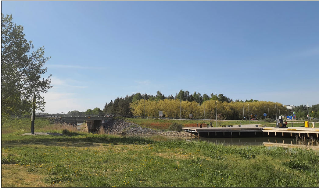
Kuva 15. Kirkkosalmi eli "Suntti" ja sen varren pienvenelaituri maantien 180 kohdalla. Valokuva © Destia Oy 05/2024.
