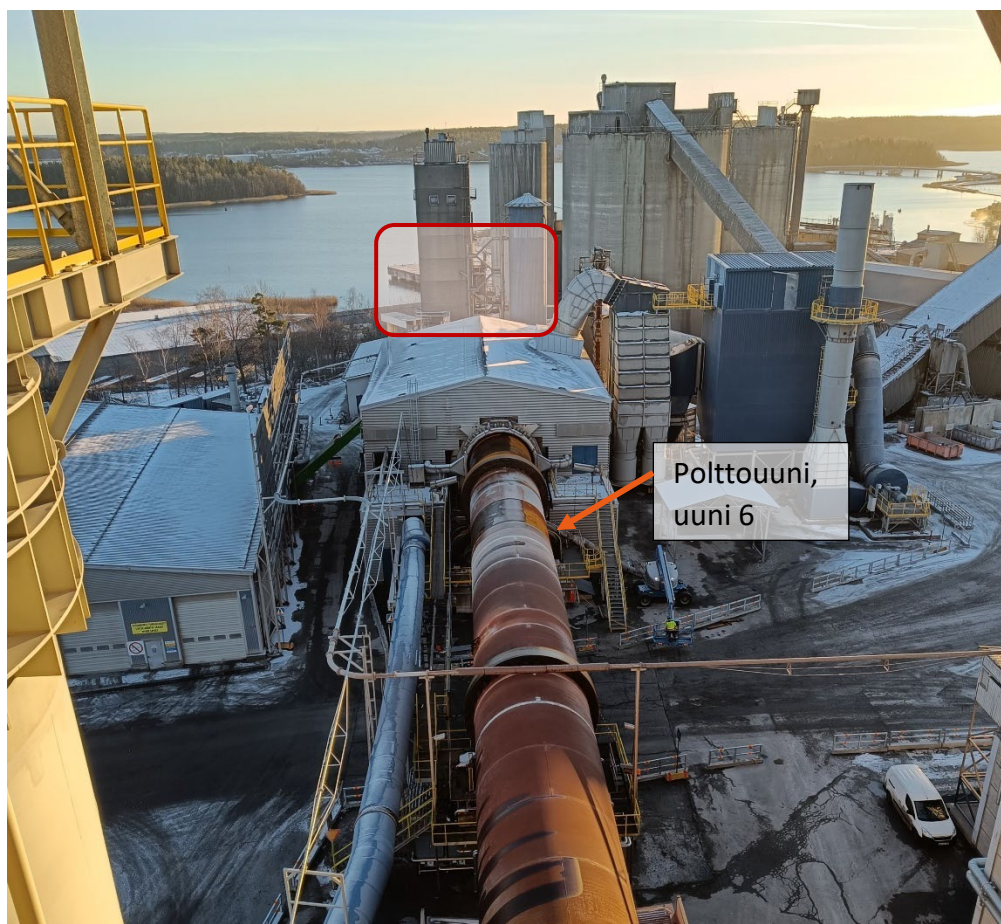
Kuva 1. Kuivaimen sijainti havainnollistettu kuvaan punareunaisella kuviolla. Kuivaimen kokonaiskorkeus jää oikealla puolella näkyvän piipun kokonaiskorkeudelle.
