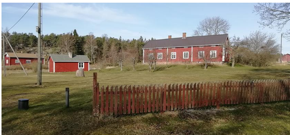
Kuva 8. Södergårdin asuinrakennus (19), sauna (12) ja päärakennus (11). Aita sijoittuu tilojen väliselle rajalle.
