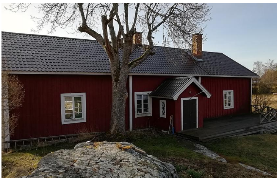
Kuva 6. Södergårdin päärakennus, kartalla nro 11.
