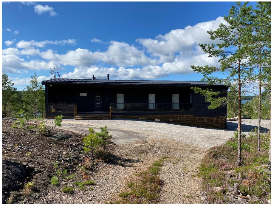
Loma-asunto korttelin 23 rakennuspaikalla 2 kiinteistöllä 445-590-1-22 Sandöstrand II.
