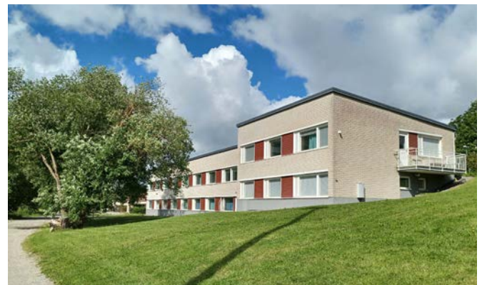
Internatbyggnad från 1960-talet Asuntolarakennus 1960-luvulta
