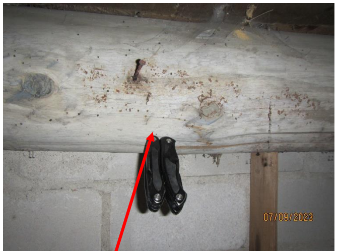
Bild 9-10. Konstruktionerna i källarutrymmet är våta ... och trävirket ställvis kraftigt rötskadat.
