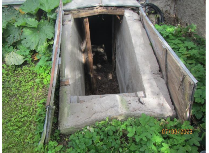
Bild 7-8. Källartrappan är sönder ..... och locket löst påsatt.
