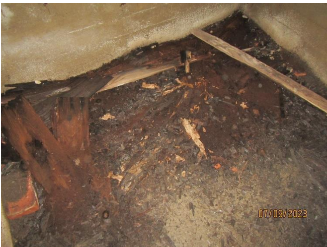
Bild 9-10. Konstruktionerna i källarutrymmet är våta ... och trävirket ställvis kraftigt rötskadat.
