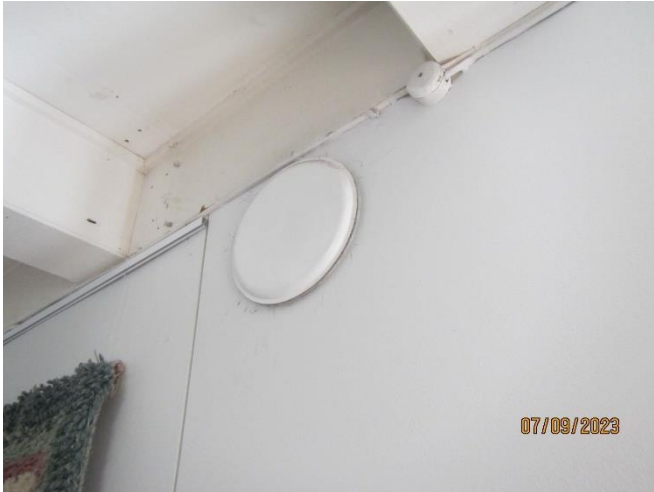
Bild 29-30. Olika friskluftsventiler i ytterväggarna.
