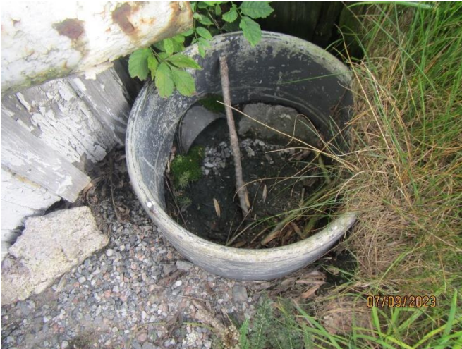
Bild 21-22. Takvattnet leds i "brunnar".
