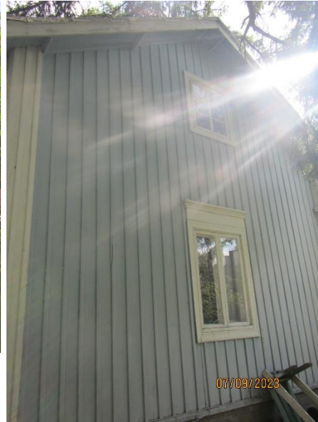
Bild 15-16. Byggnadens västra sida ..... samt -gavel.
