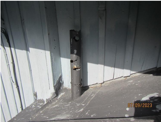
Bild 27-28. Avloppets luftningsrör på taket ..... samt gjutjärnsröret i wc:n.
