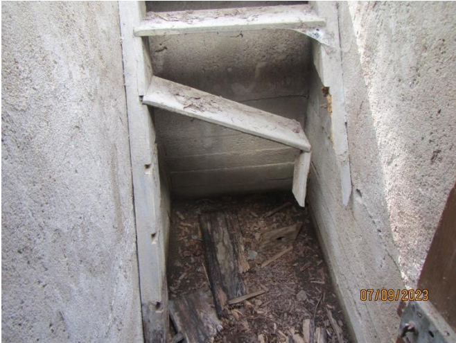
Bild 7-8. Källartrappan är sönder ..... och locket löst påsatt.
