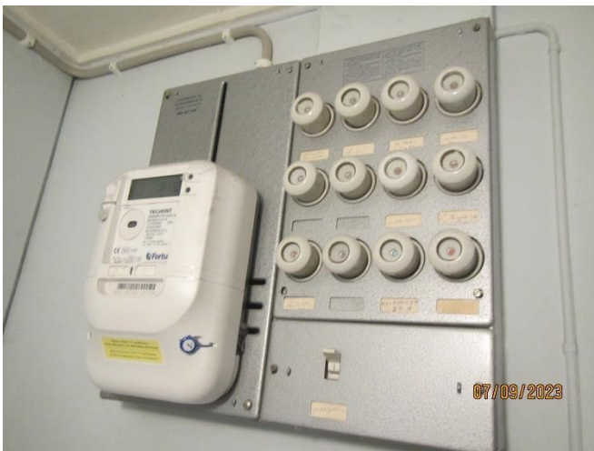
Bild 31-32. Elmätaren samt gruppcentralen.
