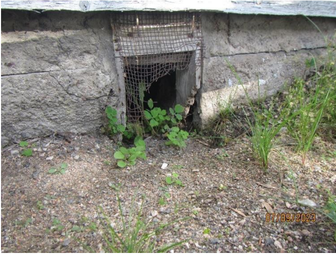
Bild 5-6. Ventilationshål i stenfoten, södra sidan.
