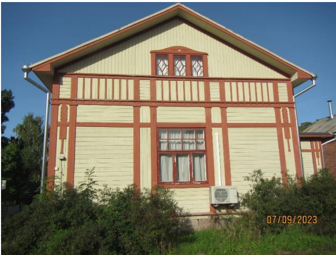
Bild 7-8. Byggnadens södra sida.
