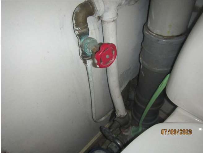
Bild 37-38. Avloppsrören är av plast.
