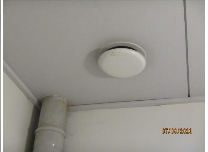
Bild 41-42. Friskluftsventil i kafferummet ..... samt frånluftsventil i wc:n.
