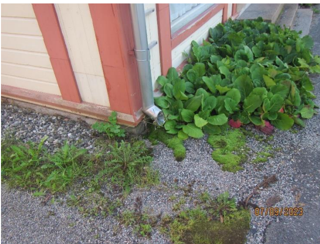
Bild 29-30. Takvattnet leds rakt ner på marken.
