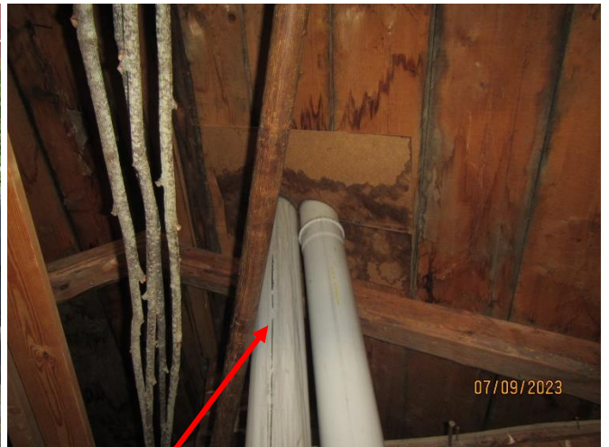
Bild 39-40. Avloppets luftningsrör på taket ..... samt på kalla vinden.
