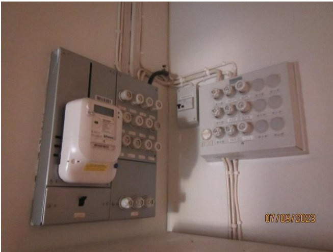
Bild 43-44. Elmätaren samt gruppcentralen.
