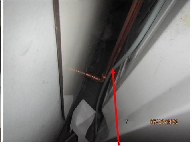
Bild 33-34. Husvattenledningen till vattenmätaren galvat rör, men bruksvattenrören mestadels kopparrör.
