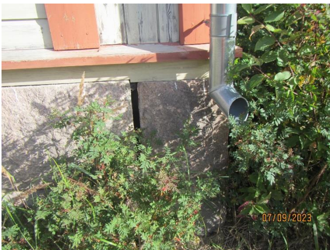
Bild 1-2. Granit-blocken har ställvis förskjutits ..... och stenfoten är ställvis låg.
