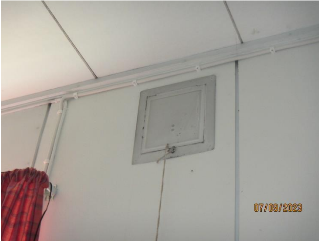
Bild 41-42. Friskluftsventil i kafferummet ..... samt frånluftsventil i wc:n.
