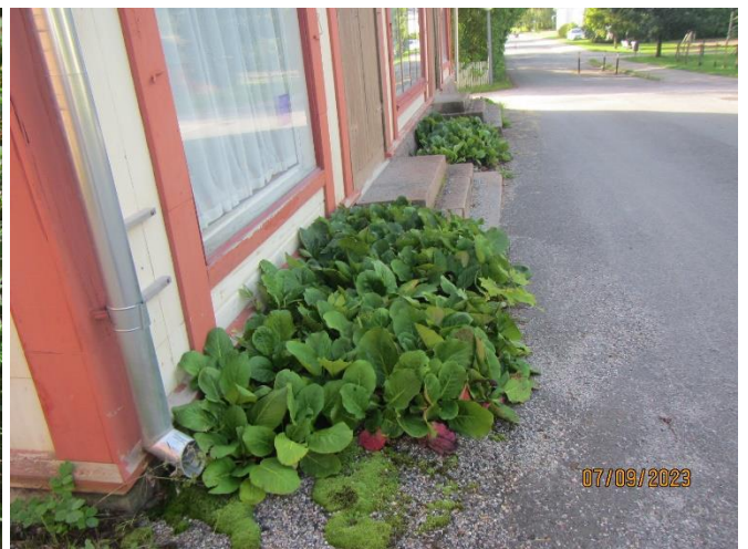
Bild 1-2. Granit-blocken har ställvis förskjutits ..... och stenfoten är ställvis låg.
