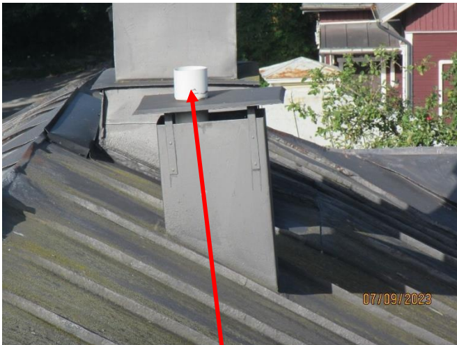
Bild 39-40. Avloppets luftningsrör på taket ..... samt på kalla vinden.
