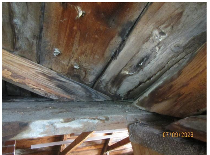
Bild 23-24. Kallvind, östra delen: Vattenhinkar utplacerade. Fuktspår i taket ovanom.
