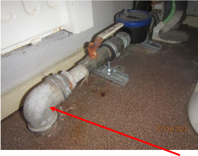
Bild 33-34. Husvattenledningen till vattenmätaren galvat rör, men bruksvattenrören mestadels kopparrör.
