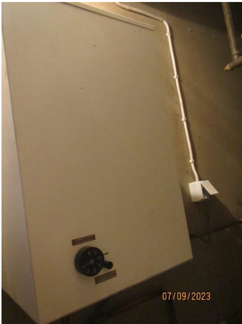
Bild 35-36. Allmän bild av varmvattenberedaren. Övertrycksvattnet leds i ett kärl, som är överfyllt.
