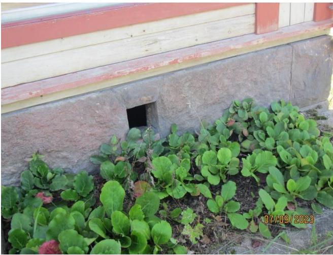
Bild 3-4. Ventilationshål i stenfoten.
