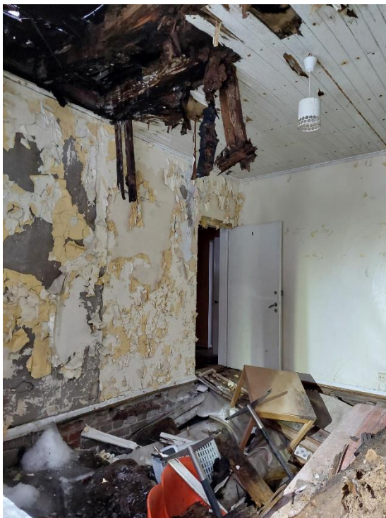
Lägenhet med mellantaket som rasat in
