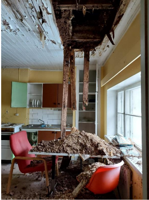
Innertaket har omfattande vatten- och rötskador och har delvis rasat in
