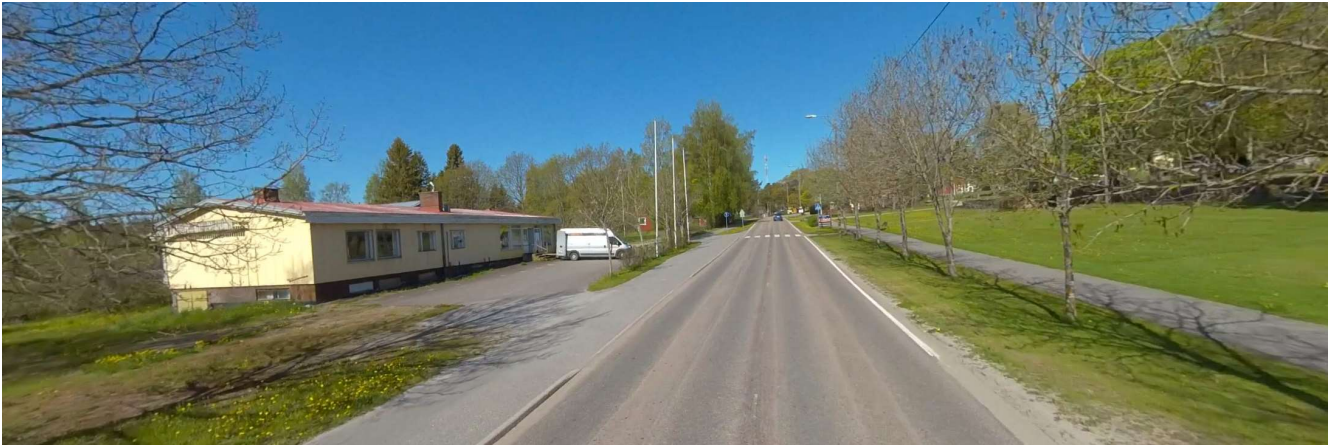
Skärgårdsvägen västerut / Saaristotie länteen
