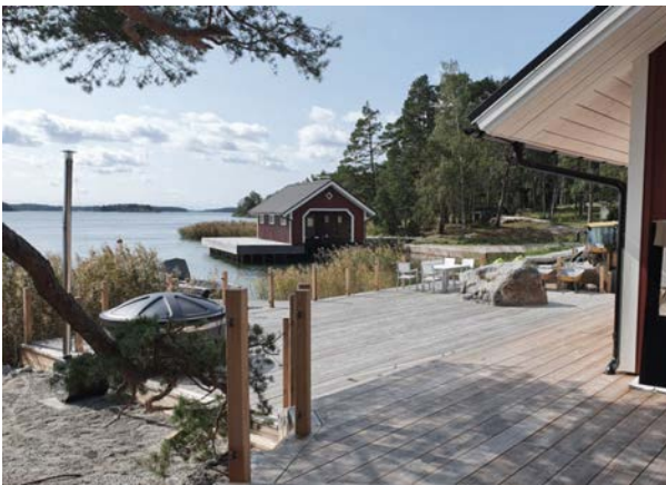
Kuva 14. Näkymä uusittu saunarakennuksesta venevajaan.
