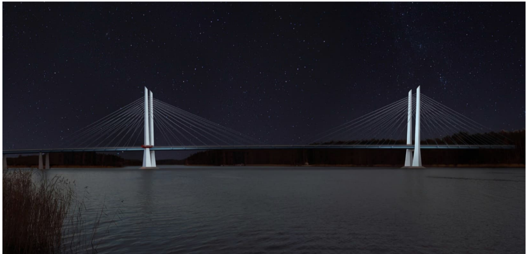
Kuva 3. Kirjalansalmen sillan valaistus.
