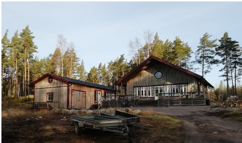
Kuva 13. Loma-asunto (21) ulkorakennuksineen (22) edustaa ainoan varsinaisen uudisrakentamisen kylässä pitkältä ajalta.
